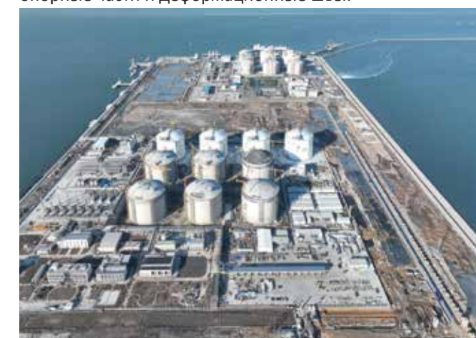
Проект резервуара для СПГ в Тяньцзине, Китай Компания OVM поставила криогенную систему преднапряжения.
